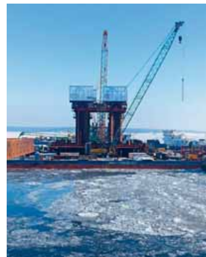
Система опускания, ящик в проектном положении
