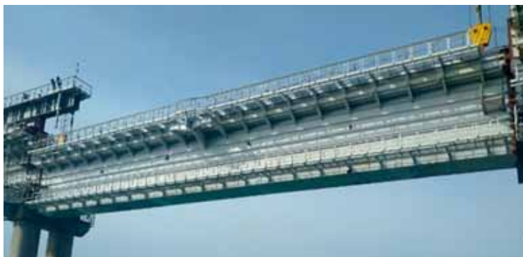
Подъем пролетного строения
