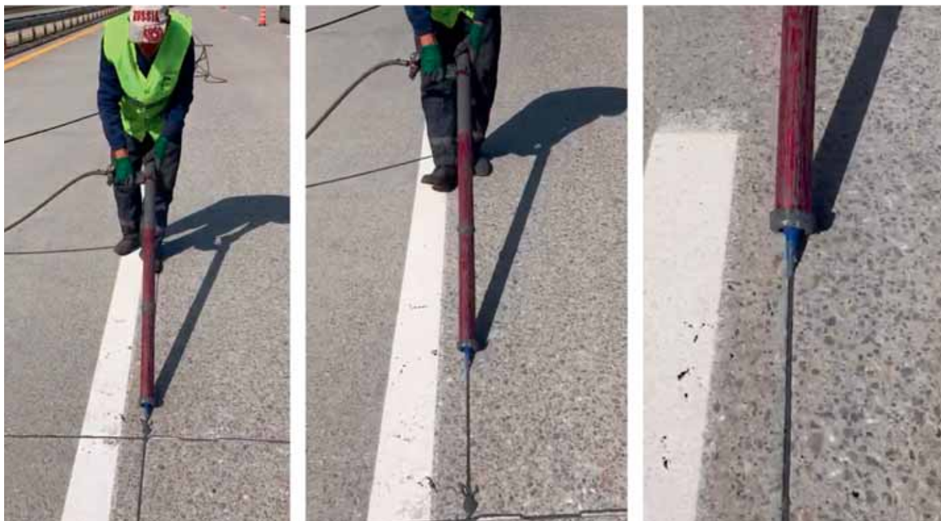
Разработанное нашей компанией оборудование для заливки шва тиоколовым герметиком в работе
