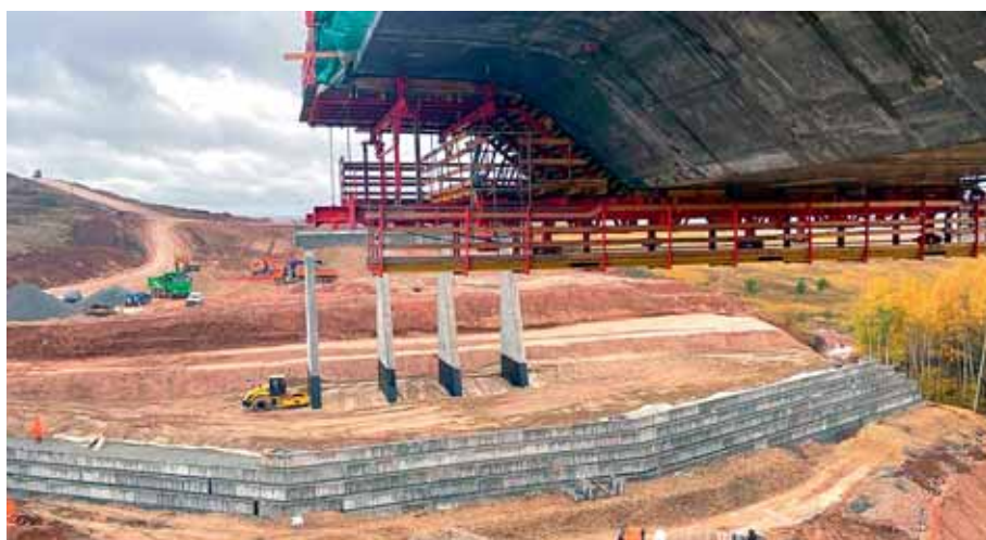
М-12, 7-й этап, мост через Осипов овраг
