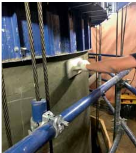
Заглаживание поверхности
