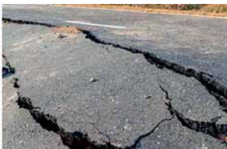
Рис. 18. Разрушение (дробление) прикромочной части асфальтобетонного покрытия по причине разрушения нижележащего слоя одежды – опоры для дорожного покрытия
