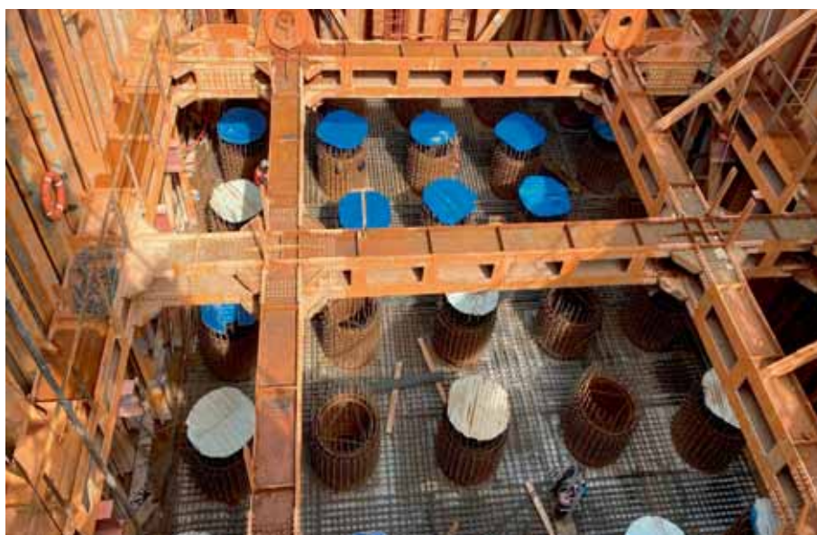
Работы по армированию ростверка в ящике
