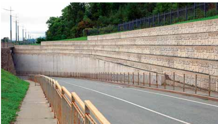
Подпорная стена на улице Маковского, Владивосток
