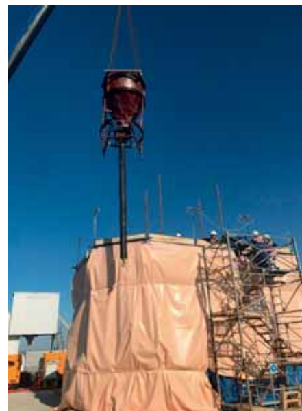
Бетонирование тела опоры
