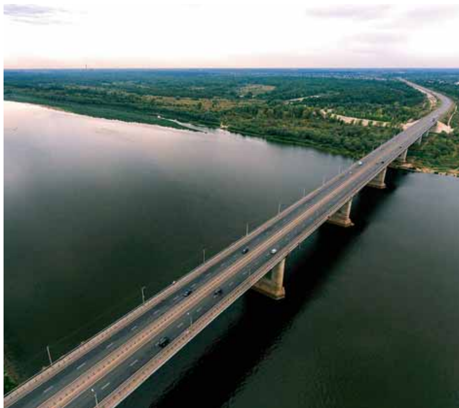
Мост через р. Оку в Нижегородской области
