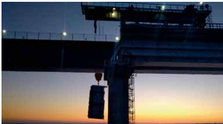
Подъем опорных блоков
