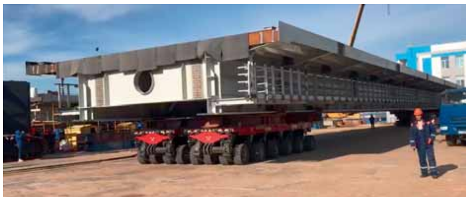
Пролетное строение на транспорте
