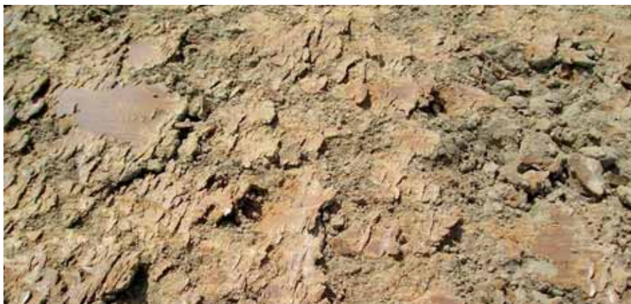
Рис. 2. Суглинок, укрепленный цементом, после уплотнения и профилирования
