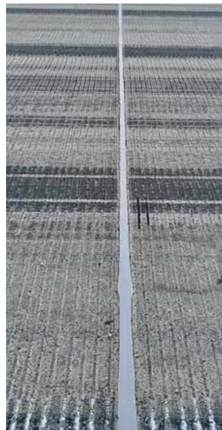
Устройство шва на ВПП
