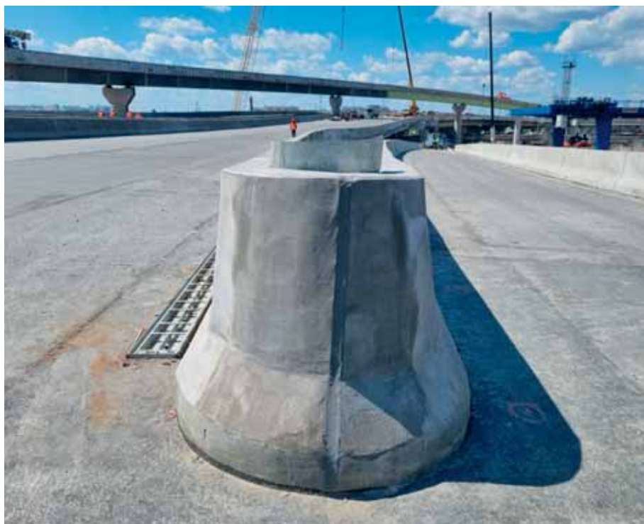
Применение тиоколового герметика на швах разделительных блоков на СДКП
