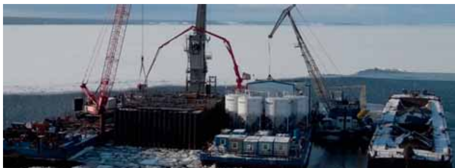
Бетонирование с использованием бетонораспределительных стрел
