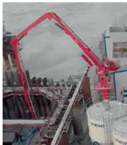
Укладка бетона в ростверк
