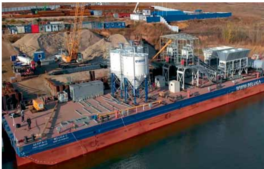
Монтаж оборудования завода на баржу
