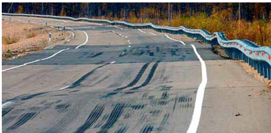
Рис. 16. Автодорога в Читинской области (весна). Результат морозного пучения грунта. Пример гибкости дорожной одежды и а/б покрытия
