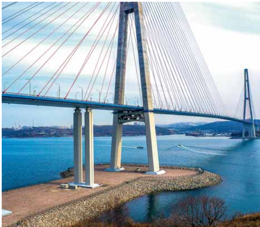
Вантовый мост через пролив Босфор Восточный (на о. Русский) в Приморском крае
