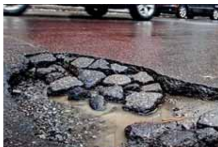
Рис. 18. Разрушение (дробление) прикромочной части асфальтобетонного покрытия по причине разрушения нижележащего слоя одежды – опоры для дорожного покрытия
