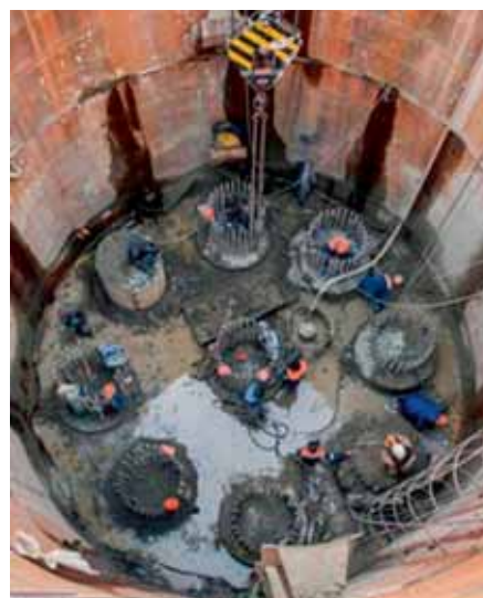
Срубка голов свай
