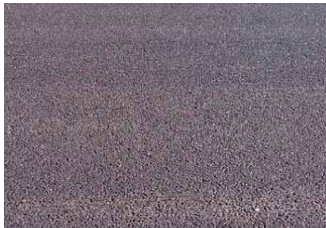
Рис. 4. Внешний вид покрытия из асфальтобетона АВГ
