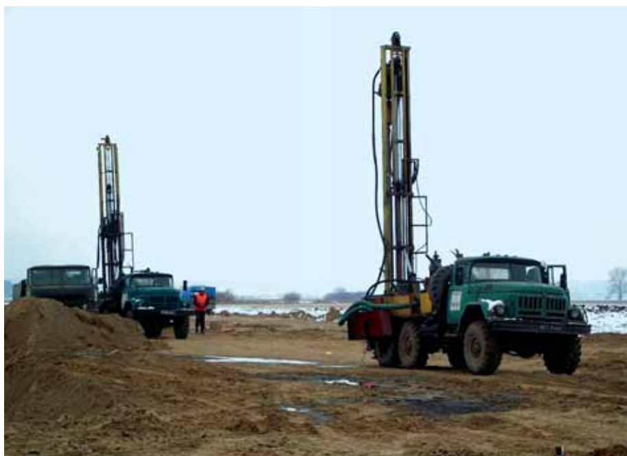
Рис. 3. Используемое буровое оборудование УРБ 2-А2
