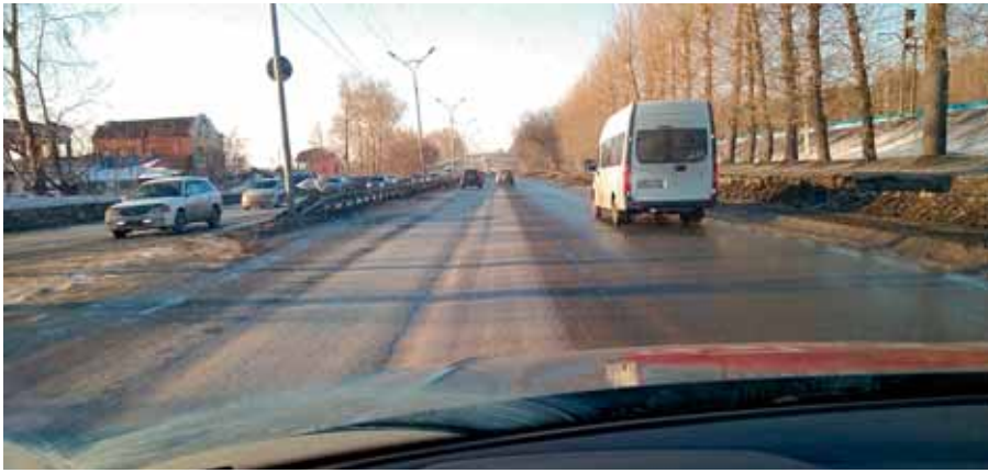
Рис. 4. Колея износа, левый ряд
