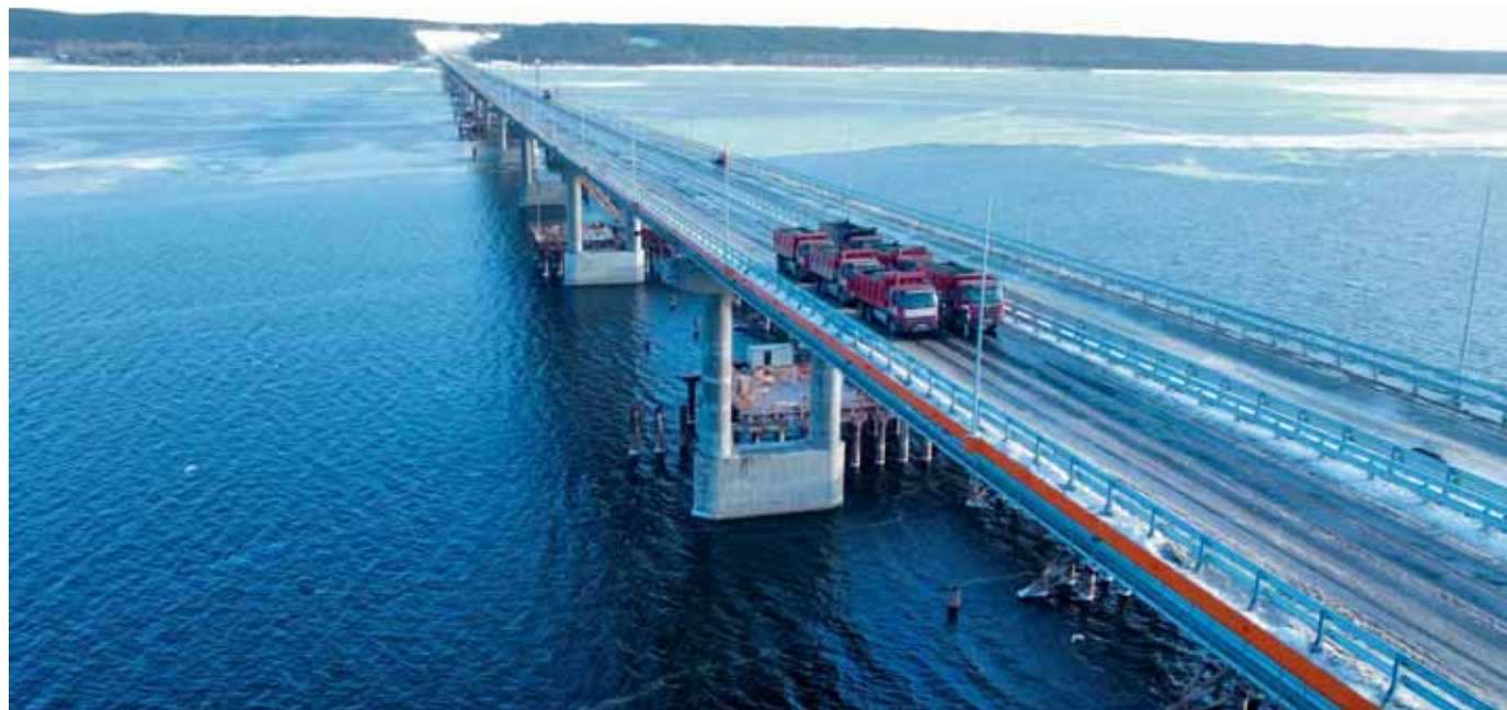
Рис. 2. Приемочные испытания моста через реку Волгу
