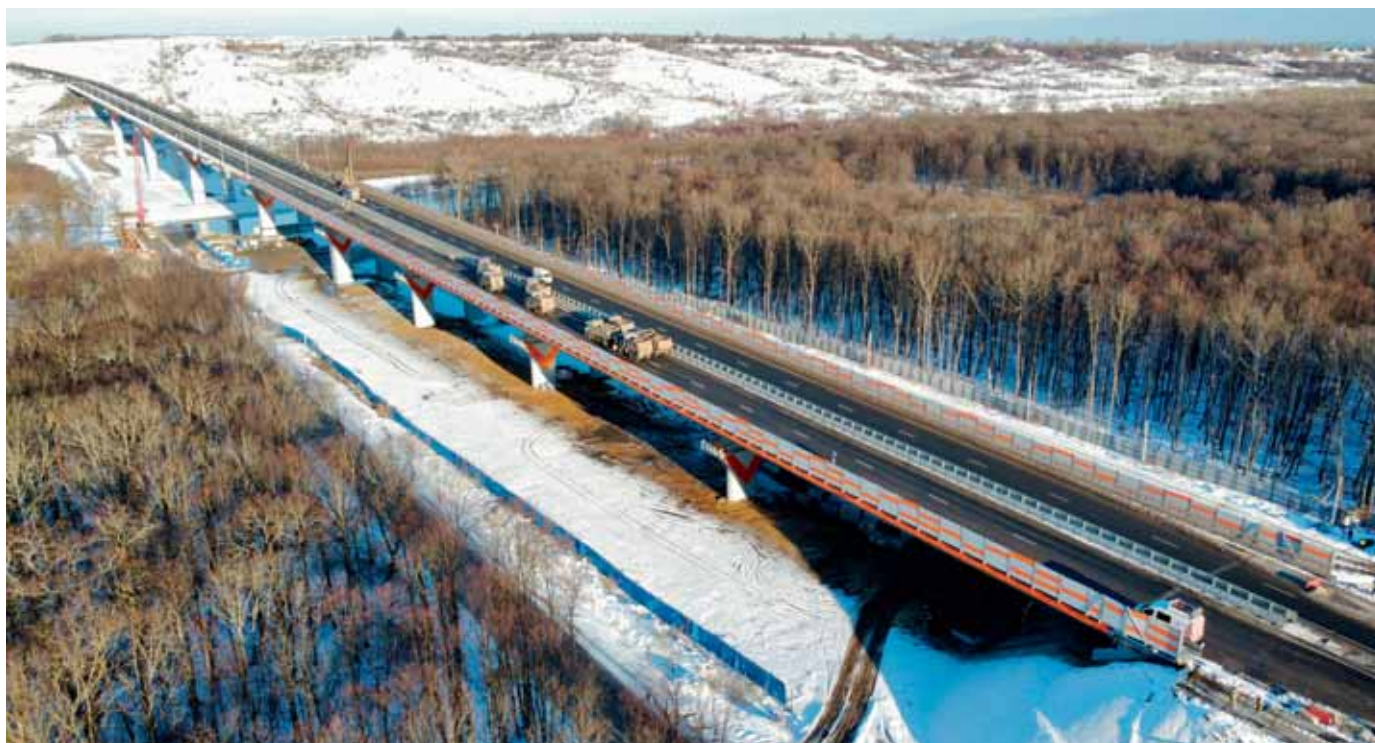
Рис. 4. Приемочные испытания моста через реку Суру
