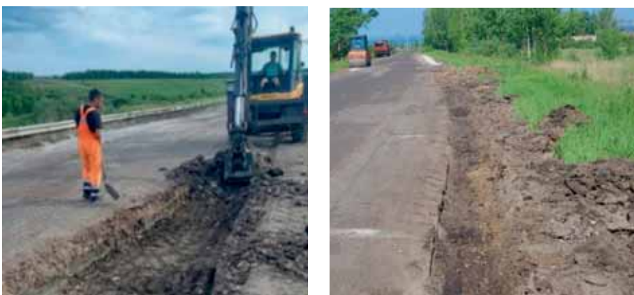
Рис. 3.2. Восстановление кромки проезжей части при ремонте автомобильной дороги
