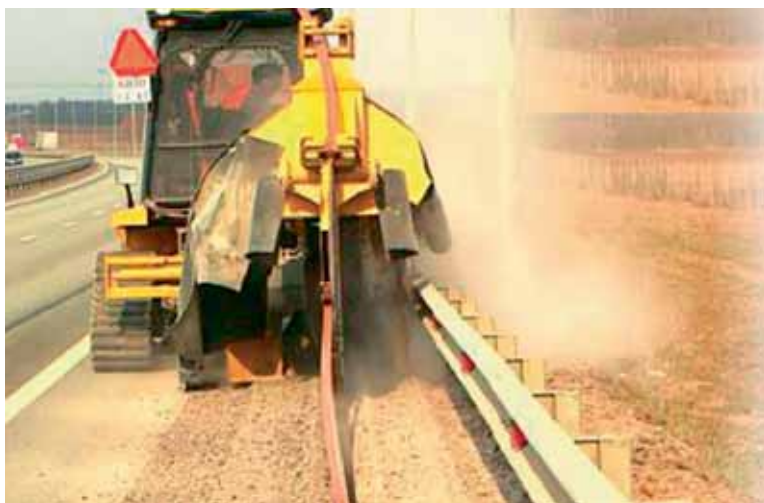
Рис. 4.1. Траншеекопатель фрезерного типа
