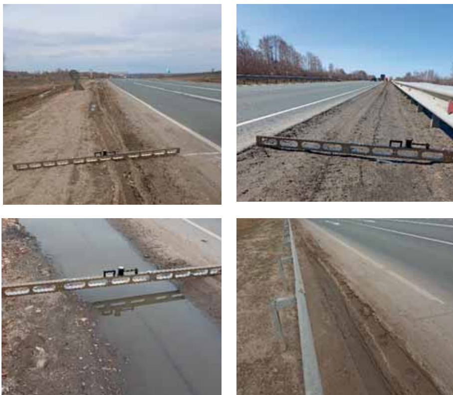
Рис. 2. Продавливание обочин под действием колесной нагрузки
