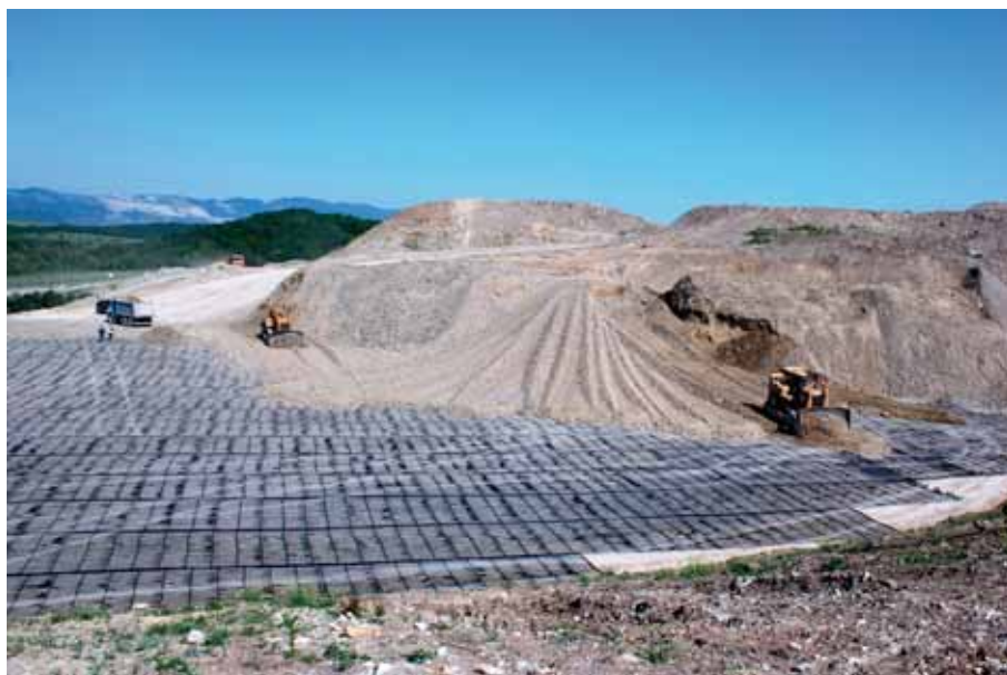
Строительство резервуара парка Каспийского трубопроводного консорциума
