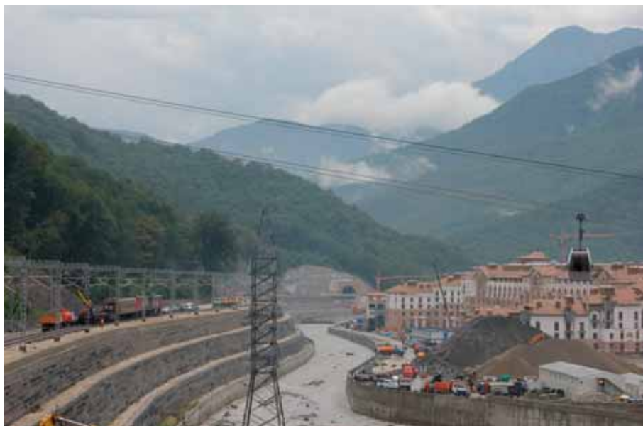
Строительство совмещенной дороги Адлер – горноклиматический курорт «Альпика-Сервис»
