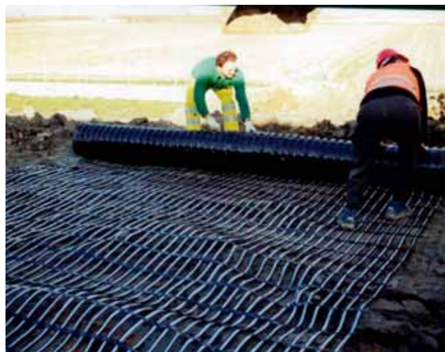
Армирование дамбы искусственного пруда для горнолыжного комплекса «Альпика-Сервис»
