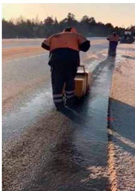
Рис. 2. Сушка дорожного покрытия перед нанесением термопластика зимой
