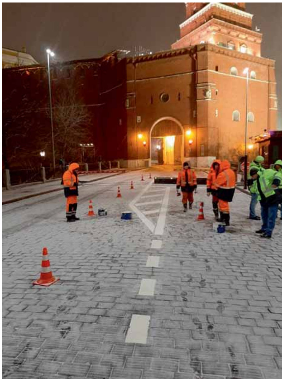
Рис. 1. Нанесение холодного пластика «Технопласт» зимой
