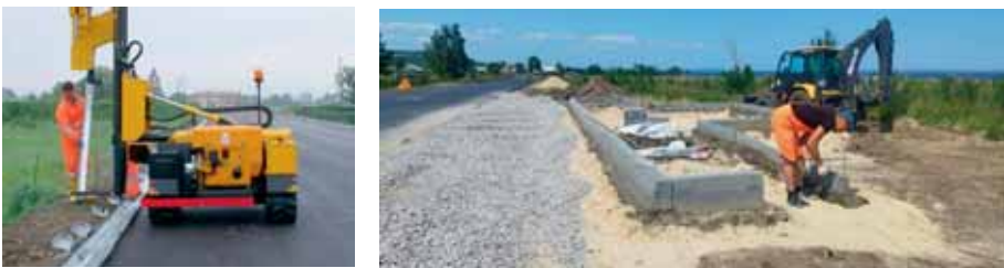
Рис. 3.3. Установка удерживающих ограждений и устройство остановки общественного транспорта
