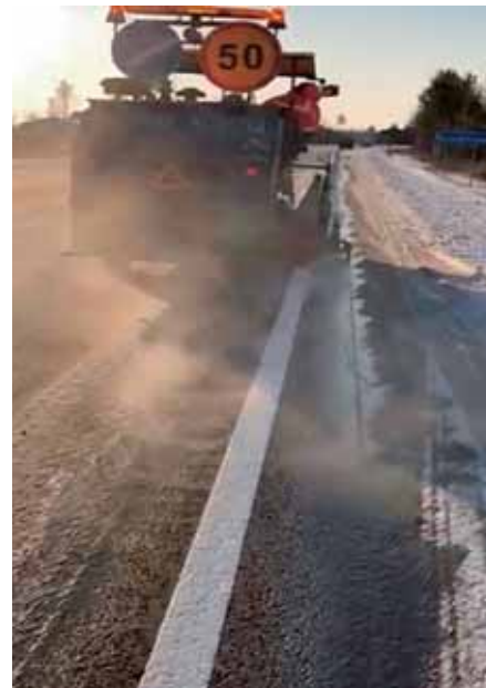
Рис. 3. Нанесение термопластика «Новопласт» зимой
