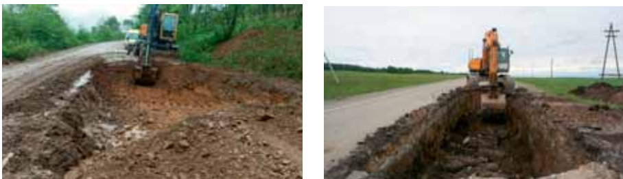
Рис. 3.1. Ремонт участка с избыточным увлажнением грунта, ликвидация пучин
