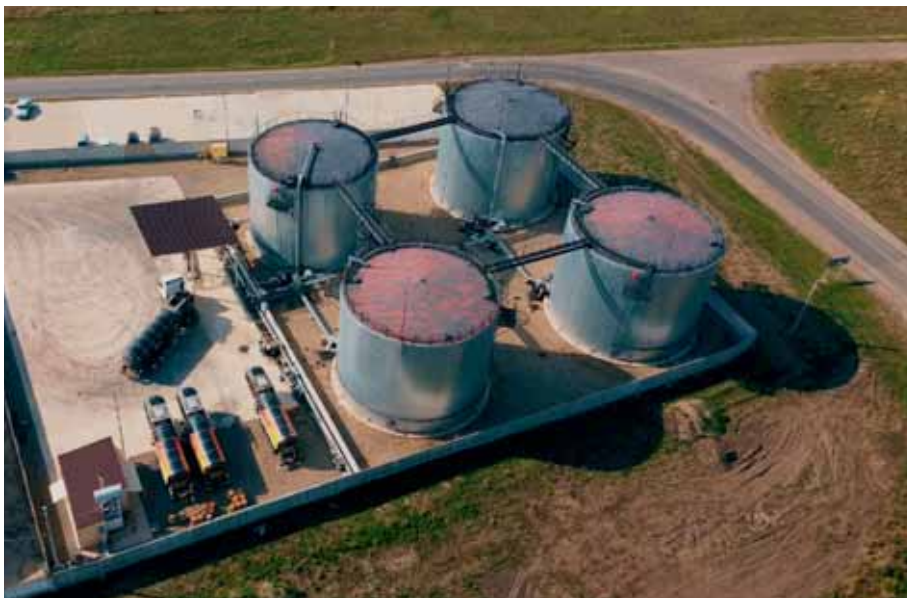
Битумный терминал с энергоэффективной технологией нагрева «Купол» от ООО «ЭБТ», г. Лабинск, Краснодарский край
