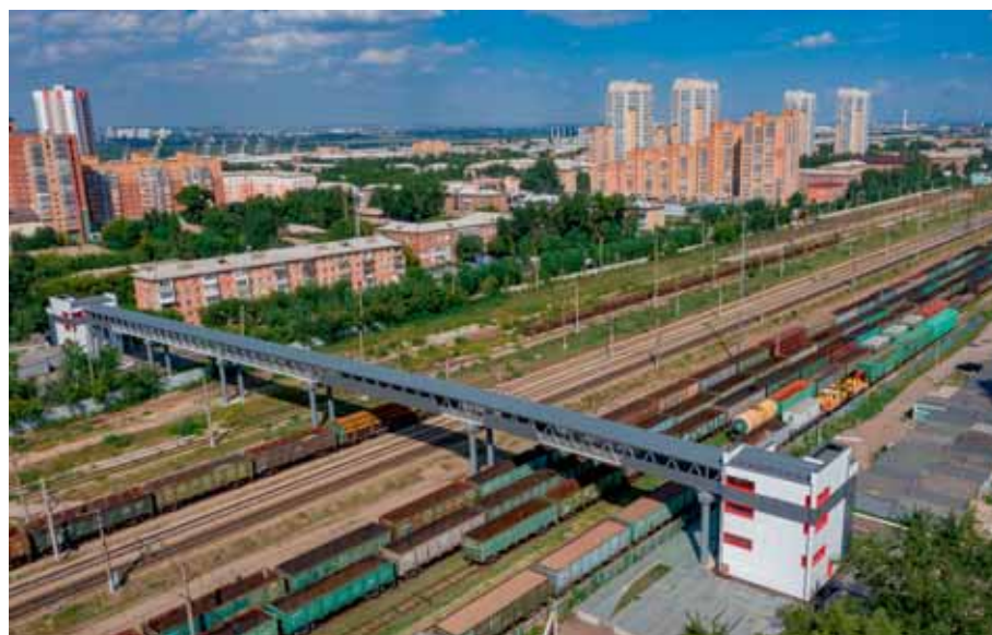
Пешеходный мост через Семафорную улицу и пути Транссиба в Красноярске
