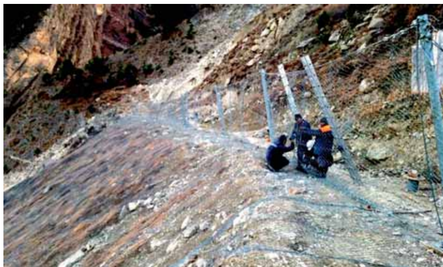
Рис. 9. Установка камнеулавливающего барьера, Готцатлинская ГЭС
