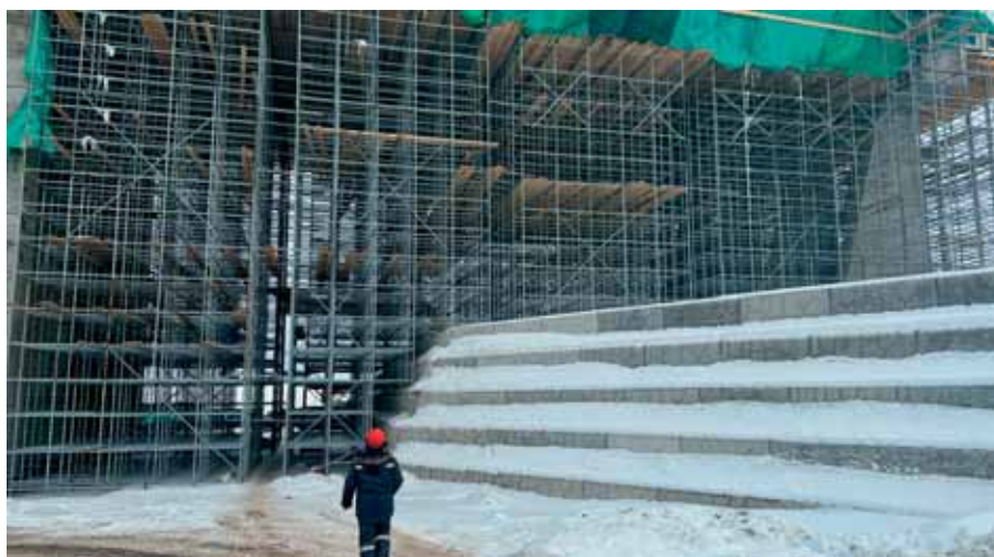
М-12, 7-й этап, мост через реку Шаратка
