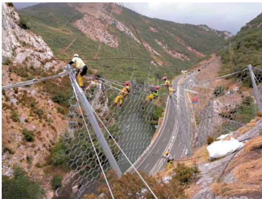
Рис. 6. Установка камнеулавливающего барьера
