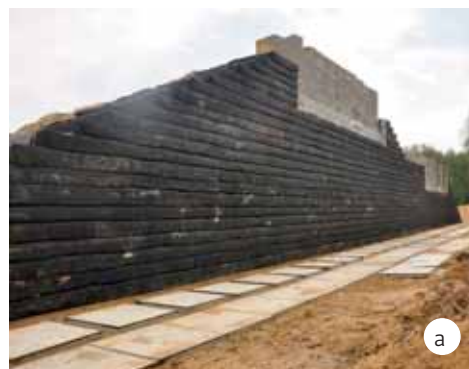
Рис. 6. Мостовой устой диванного типа: а – процесс строительства с использованием пригруза в зоне будущего диванного блока; б – окончание строительства с облицовкой блоками InorBlock
