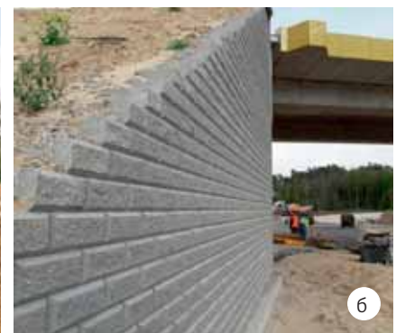
Рис. 6. Мостовой устой диванного типа: а – процесс строительства с использованием пригруза в зоне будущего диванного блока; б – окончание строительства с облицовкой блоками InorBlock
