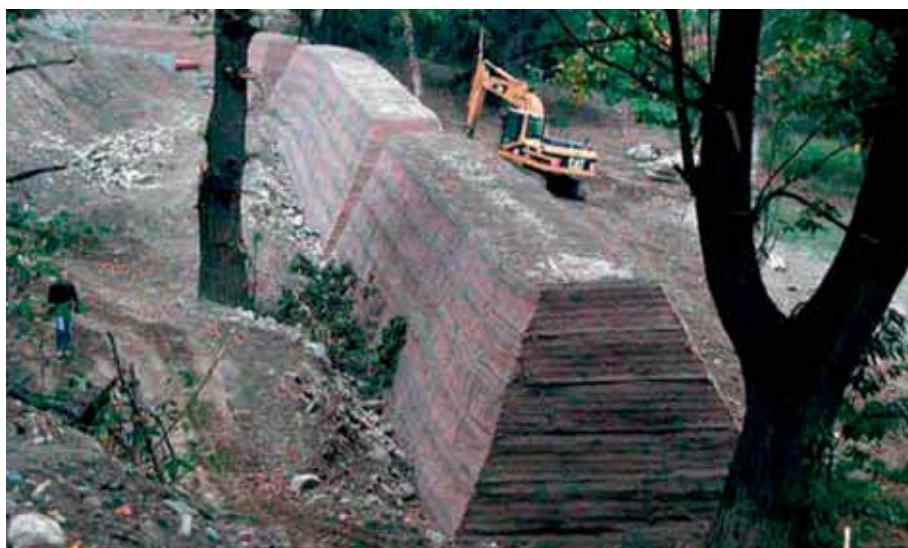
Рис. 11. Армогрунтовая камнеулавливающая насыпь по технологии «Зеленый Террамеш®»
