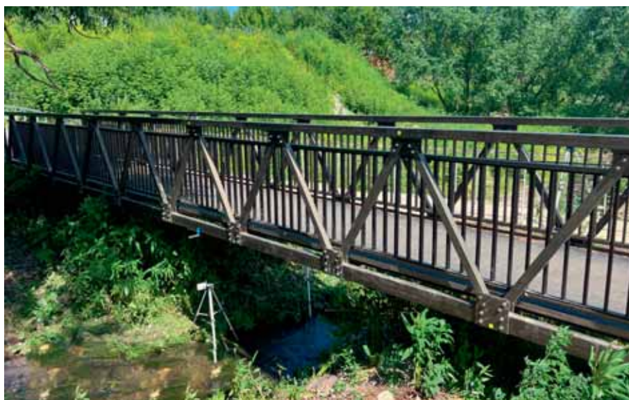
Полностью готовый мостокомплект монтируется на объекте за несколько часов
