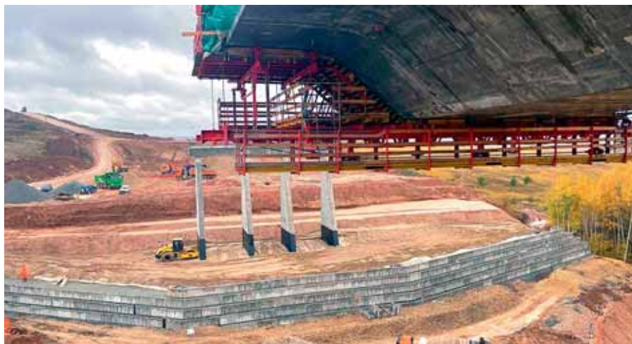
М-12, 7-й этап, мост через Осипов овраг
