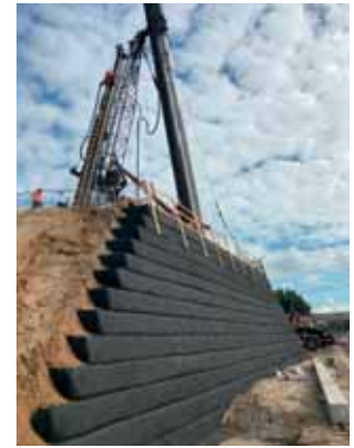
Рис. 4. Возведение опоры моста на армогрунтовой подходной насыпи. Бразилия, 2021
