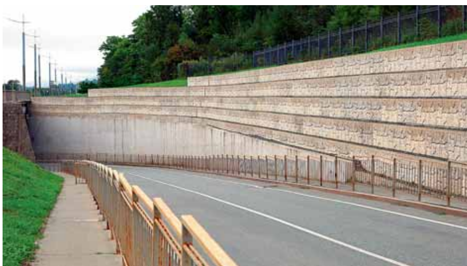
Подпорная стена на улице Маковского, Владивосток
