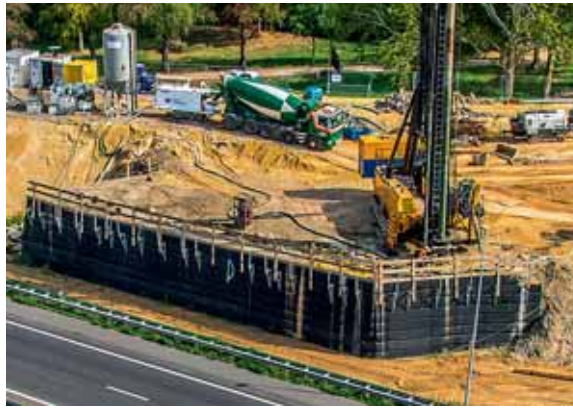
Рис. 4. Возведение опоры моста на армогрунтовой подходной насыпи. Бразилия, 2021
