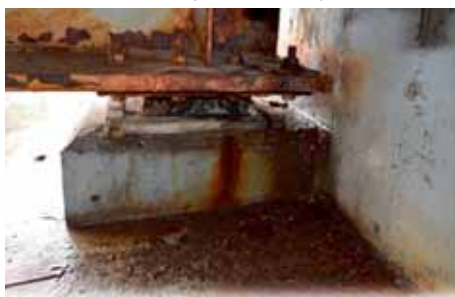
Рис. 4. Дефекты в железобетонных конструкциях мостов, возникающие от воздействия агрессивной среды
