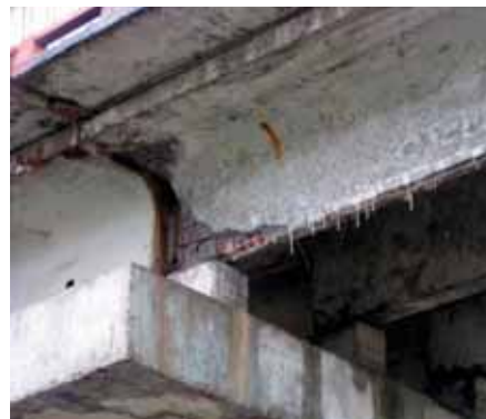
Рис. 3. Дефекты в железобетонных конструкциях мостов, возникающие от воздействия агрессивной среды
