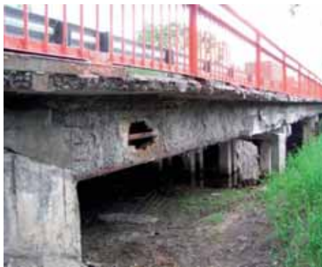
Рис. 3. Дефекты в железобетонных конструкциях мостов, возникающие от воздействия агрессивной среды
