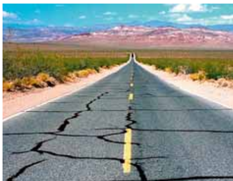
Рис. 3. Поперечные и косые трещины. Сетки усталостных трещин. Формирование выбоины в месте расположения поперечной трещины
