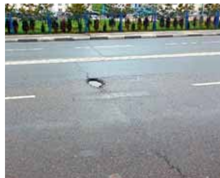
Рис. 3. Поперечные и косые трещины. Сетки усталостных трещин. Формирование выбоины в месте расположения поперечной трещины
