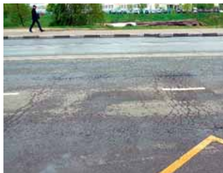
Рис. 3. Поперечные и косые трещины. Сетки усталостных трещин. Формирование выбоины в месте расположения поперечной трещины
