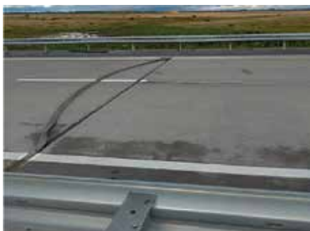
Рис. 6. Очень тонкий слой герметика
