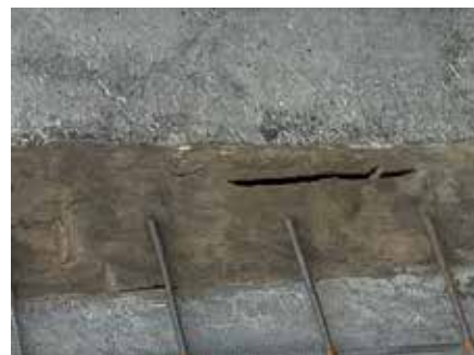
Рис. 7. Очень толстый слой герметика
