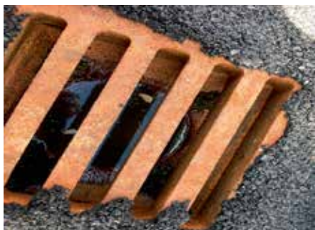
Фото 1, 2, 3. Забитые водоотводные воронки. Дренажные системы не работают. Фото выполнены на разных объектах
