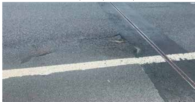
Фото 14. «Трамплин на деформационном шве». Наличие воды на обочине свидетельствует о нерабочей дренажной системе
