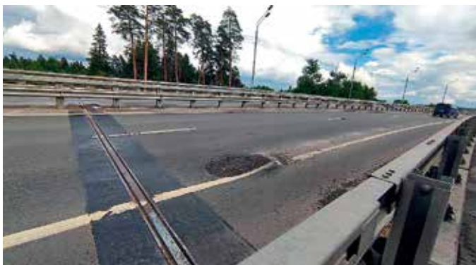
Фото 13. «Трамплин на деформационном шве»
