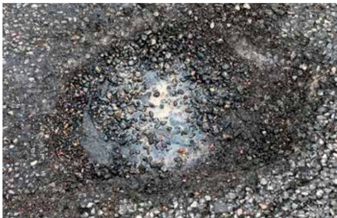
Фото 4, 5. Вода в выбоине и вода, выходящая через конструкцию деформационного шва, указывают на нарушение в работе дренажной системы
