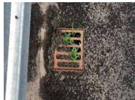
Фото 1, 2, 3. Забитые водоотводные воронки. Дренажные системы не работают. Фото выполнены на разных объектах
