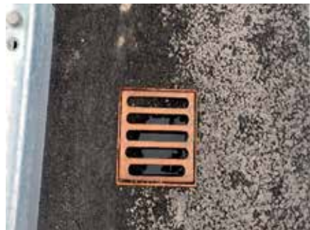
Фото 1, 2, 3. Забитые водоотводные воронки. Дренажные системы не работают. Фото выполнены на разных объектах
