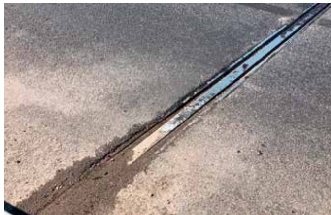
Фото 4, 5. Вода в выбоине и вода, выходящая через конструкцию деформационного шва, указывают на нарушение в работе дренажной системы
