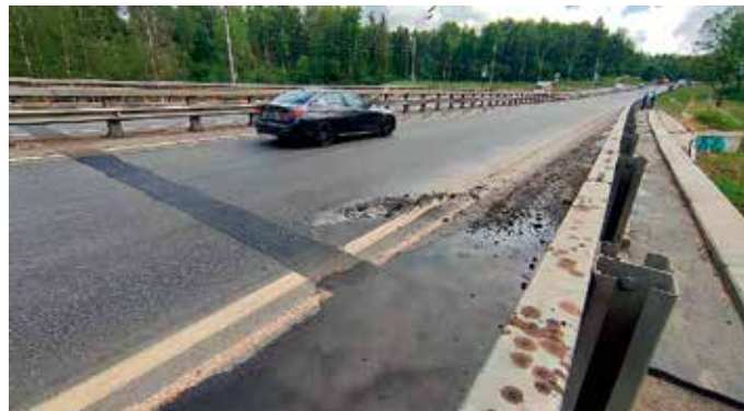
Фото 14. «Трамплин на деформационном шве». Наличие воды на обочине свидетельствует о нерабочей дренажной системе
